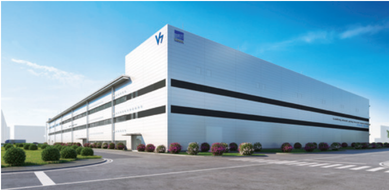
藤沢事業所(V7棟)のドライ真空ポンプ自動化ライン用設備に投資
