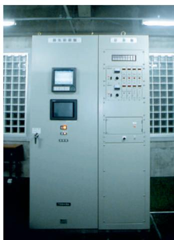
写真3 換気制御盤・計測盤
