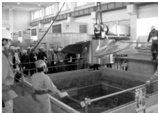
口径3600 mm 立軸軸流ポンプ/インペラ現地据付時の状況
