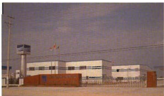
办公楼、工厂全景
