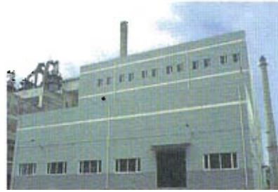
废弃物处理设施 施工例
