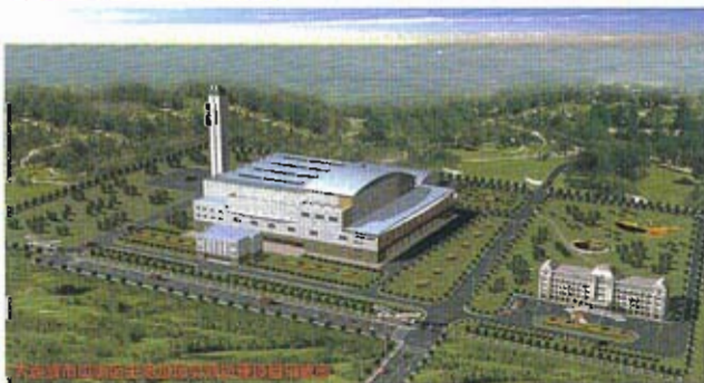
辽宁省大连市垃圾处理项目(2000吨/日)
